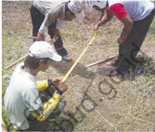
Gambar 5.1 Seorang Tukang sedang mengukur kesikuan lahan
